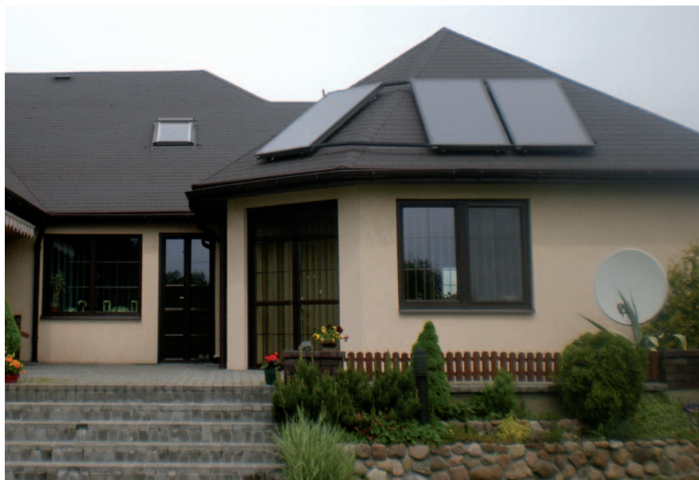
Rysunek 4. Słoneczne kolektory płaskie zamontowane na dachu budynku 7
