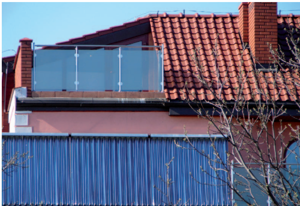
Rysunek 6. Kolektory próżniowe zamontowane na fasadzie budynku jednorodzinnego 8
